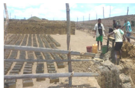
Un jeune avec l'aide de sa famille prépare des briques pour la construction du futur bâtiment d'élevage
